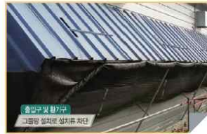
축사 입구 그물망 설치
