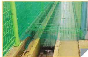
배수구 그물망 설치
