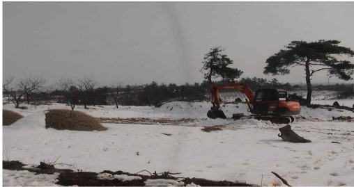
살처분 저장조 시설전 토목평탄작업
