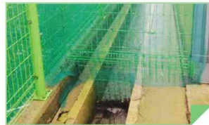
배수구 그물망 설치
