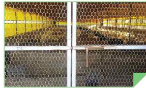
축사 입구 그물망 설치
